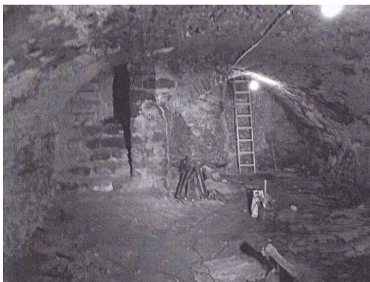
Vue générale de la cave
