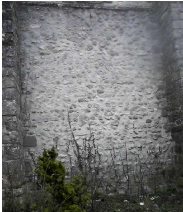
Opus spicatum (mur nord de la nef)
