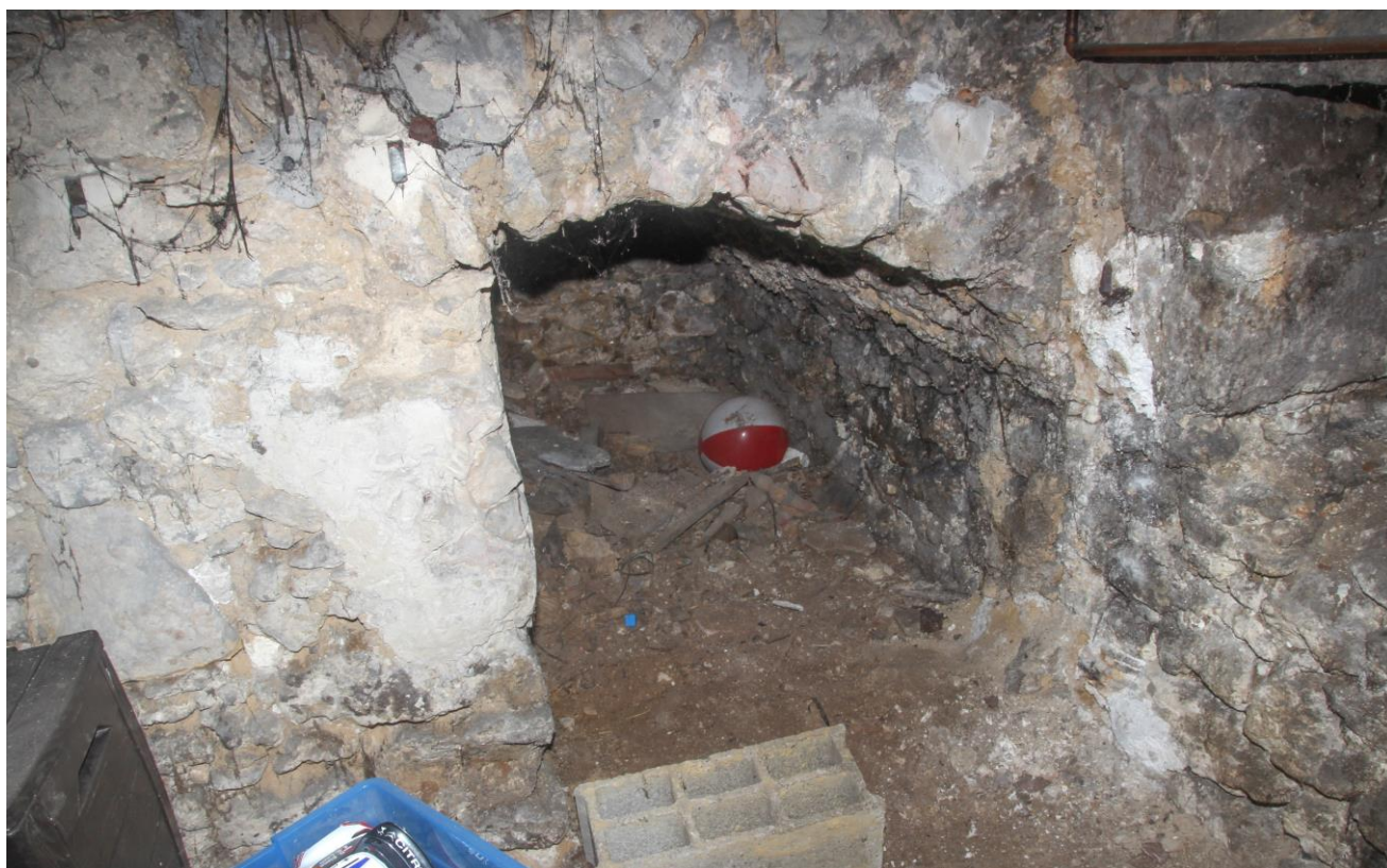
Accès au petit caveau
