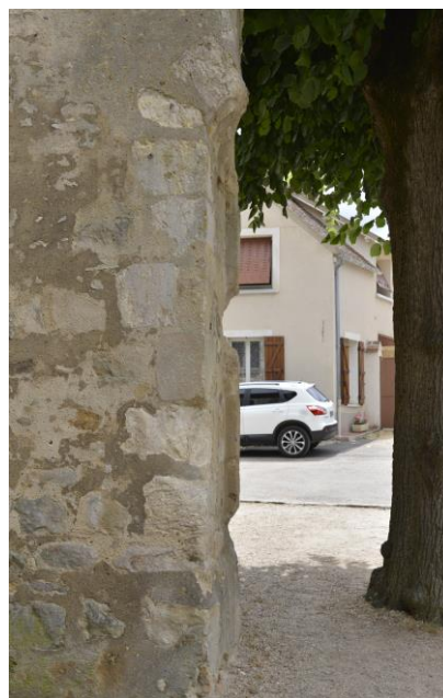
2 jambages de porte sud
