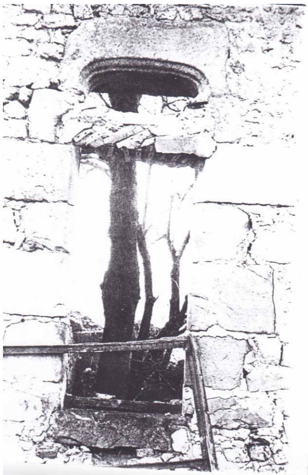
Le linteau de fenêtre encore en place
