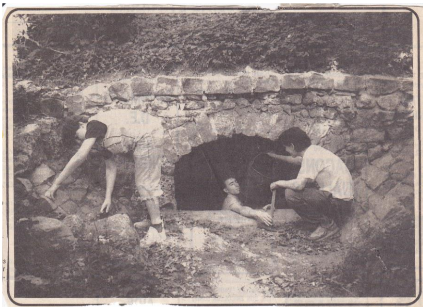
Travaux du CRDMA à la fontaine de Fourches en 1991.
