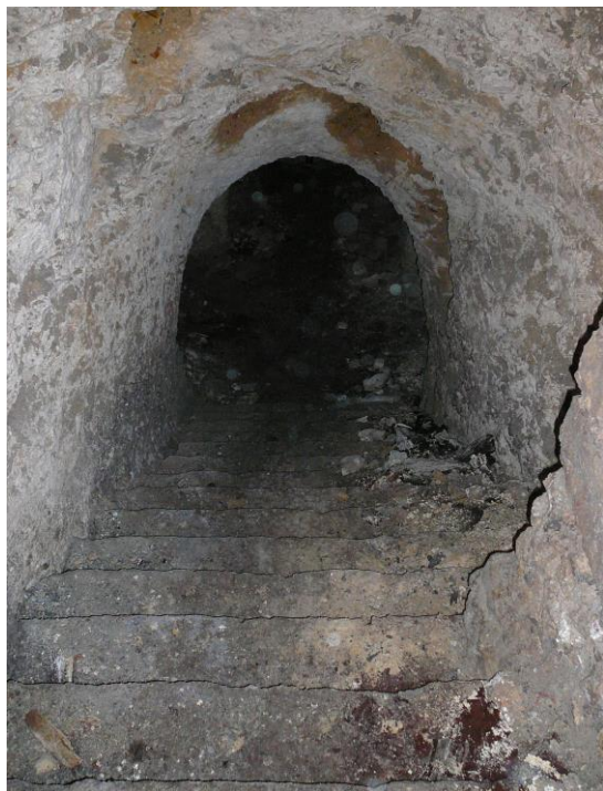
Galerie de descente d'escalier
