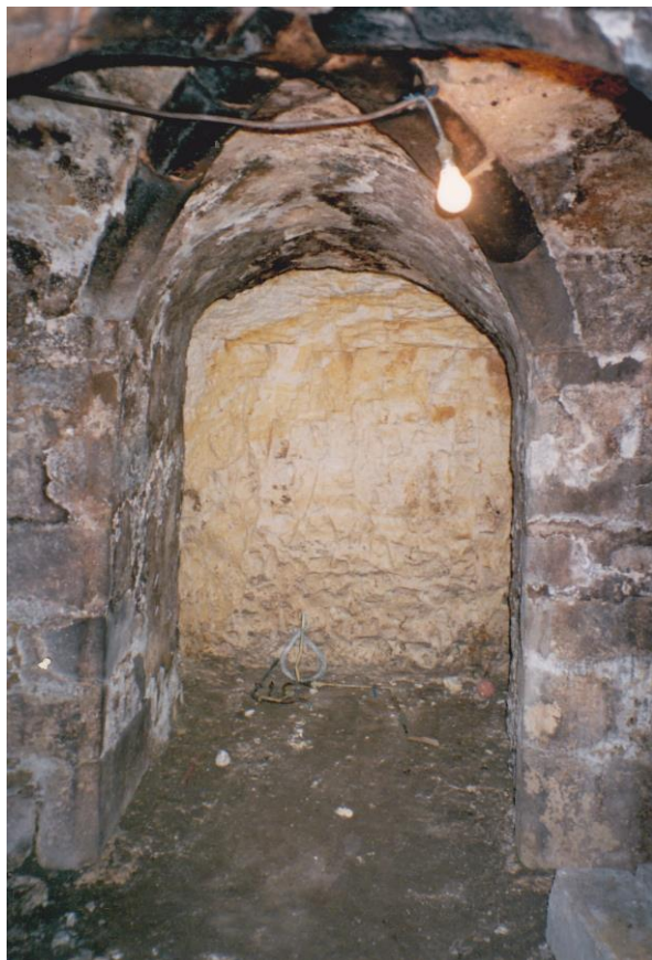
Fond d'alvéole matérialisé par le tuf calcaire
